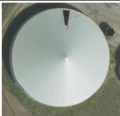
Figur 2.3: Lagertank for afgasset biomasse, som er udført med fast teltoverdækning. På siden af tanken en mindre beholder, som står i åben forbindelse med lagertanken. Fra beholderen kan tankbiler med selvansugende pumpe afhente afgasset biomasse.
